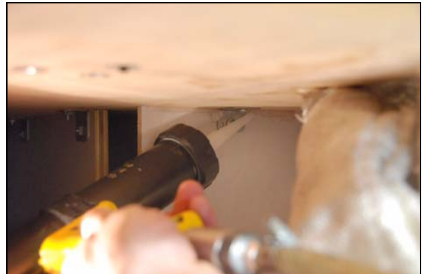
Abb.: ggfs. Dichtmasse mit dem Finger auftragen
