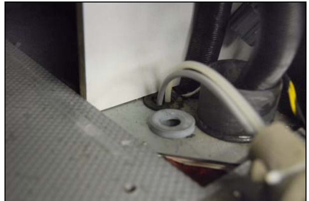
Abb.: Winkel am Boden anschrauben
