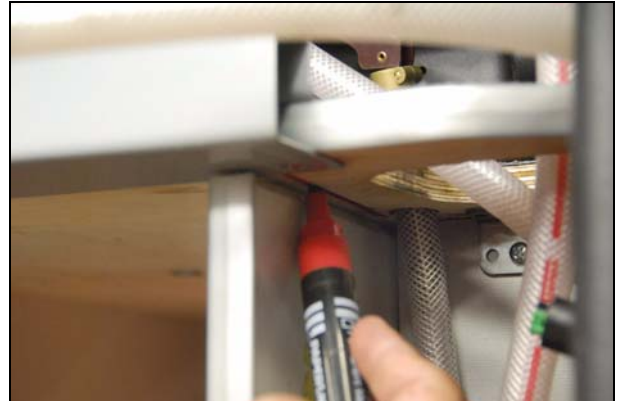
Abb.: neue Löcher rechts des Striches bohren
