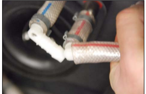
Abb.: Kaltwasseranschluss sichern
