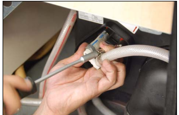
Abb.: Warmwasseranschluss sichern
