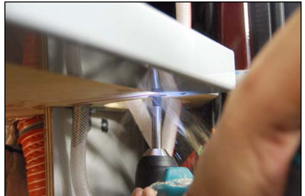
Abb.: neue Löcher zum Durchstecken der Ablassschläuche
