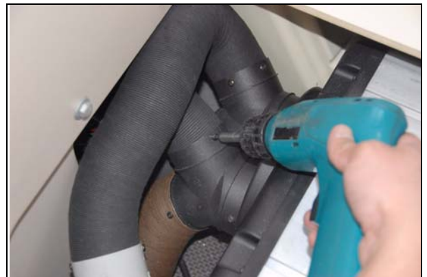
Abb.: die beiden oberen Rohranschlüsse markieren
