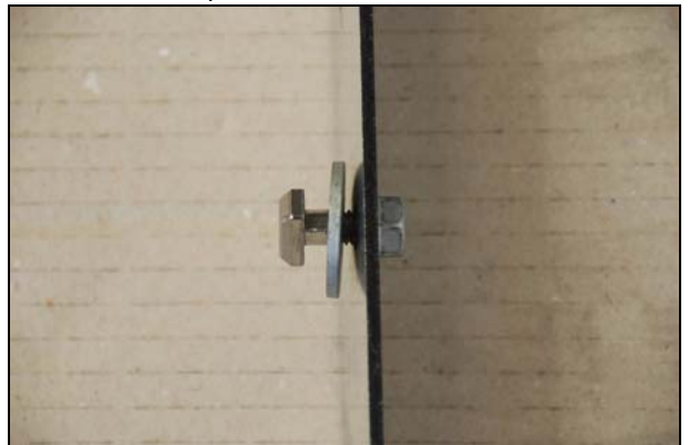
Abb.: rechter Halter mit Hammerkopfschrauben
