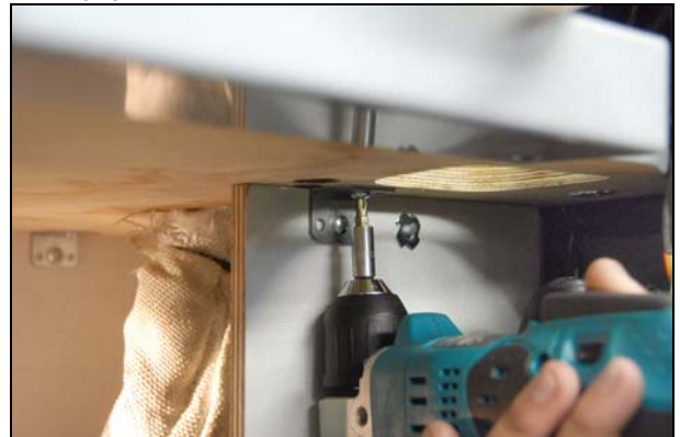
Abb.: gegebenenfalls Zusatzwinkel verwenden
