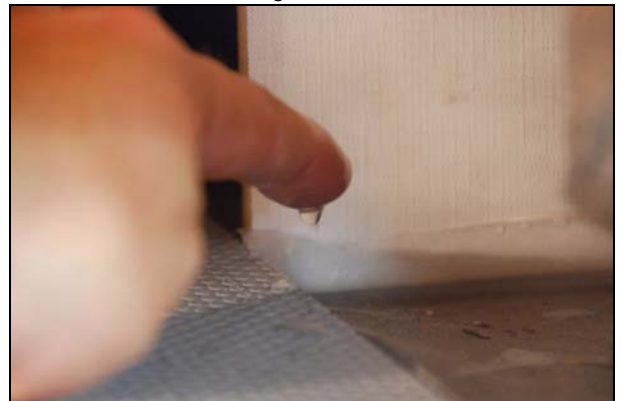
Abb.: breite Dichtmassenschnur an der Unterkante
