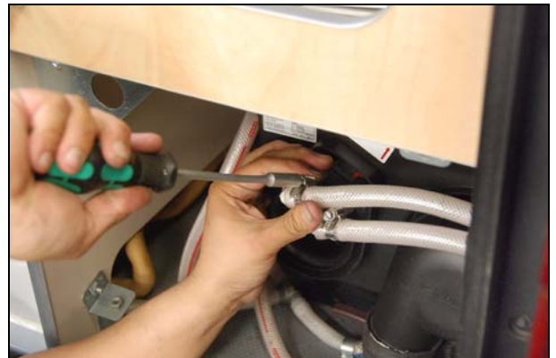
Abb.: Führung der beiden Brauchwasserschläuche
