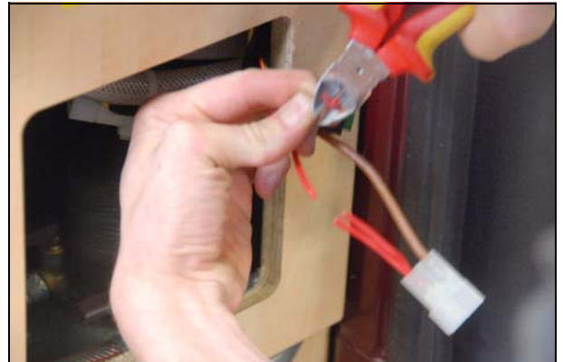
Abb.: Flachkontakte aufquetschen
