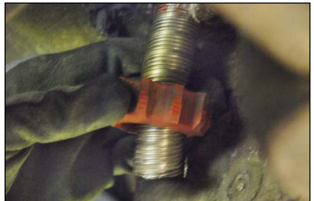
Abb.: Quetschmuffe überschieben
