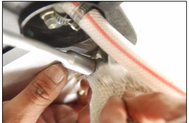
Abb.: Ummantlung mit Kabelbinder fixieren
