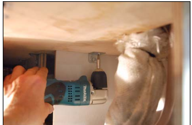
Abb.: gegebenenfalls Zusatzwinkel verwenden
