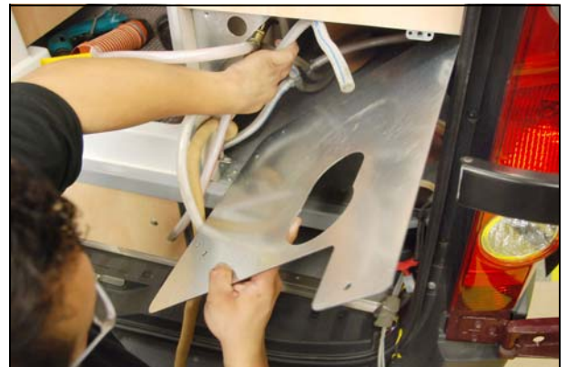
Abb.: Bodenblech positionieren
