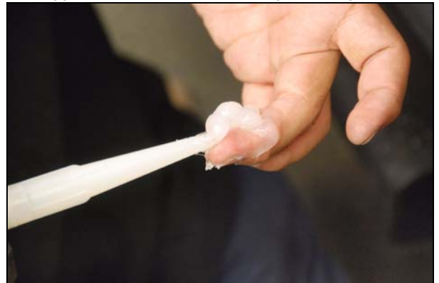
Abb.: Dichtmasse mit Abglättmittel abziehen
