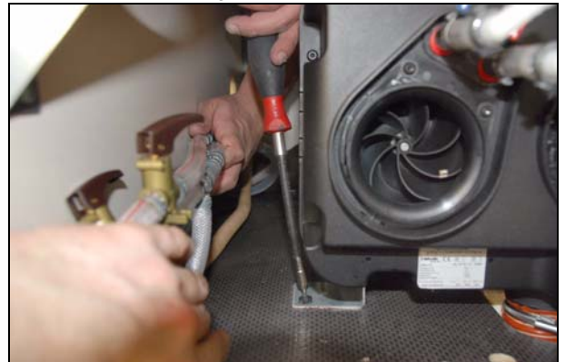
Abb.: untere Halterungen losschrauben
