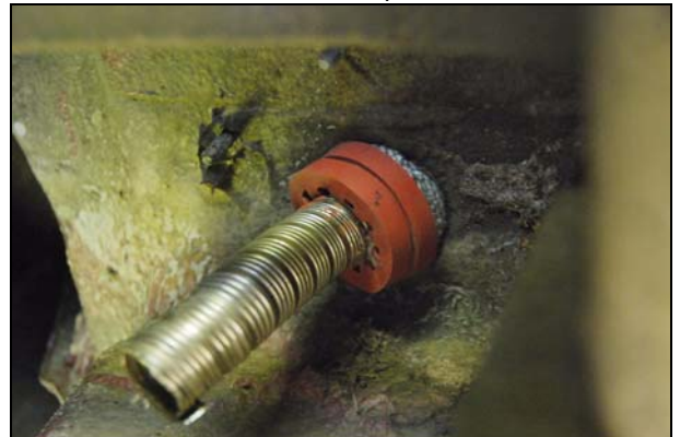
Abb.: gezahnten Ring aufschieben
