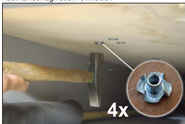
Abb.: Einschlagmuttern mit Schraube ganz einziehen
