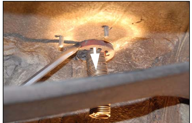
Abb.: Quetschmuffe Auf links ziehen und abziehen
