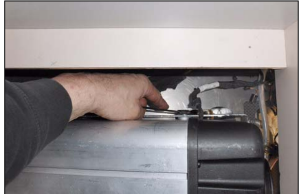
Abb.: Heizung mit beiden Haltern
