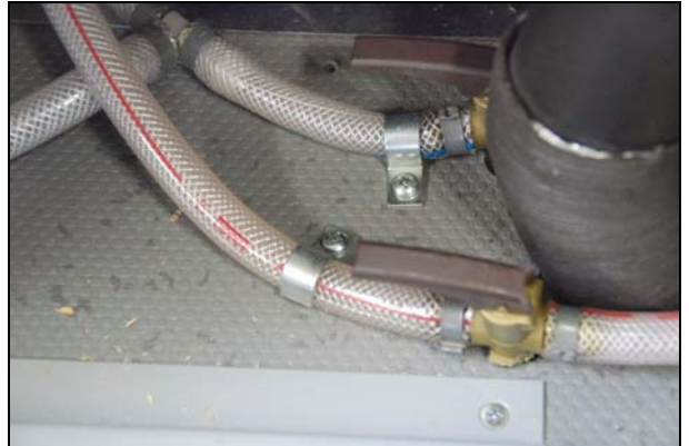
Abb.: Ablasshähne müssen ganz geöffnet werden können
